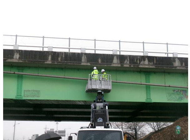
고소작업차를 이용한 근접조사
