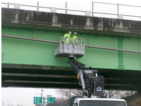
고소작업차를 이용한 근접조사
