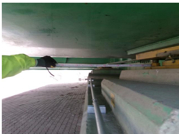
받침장치 연단거리 측정
