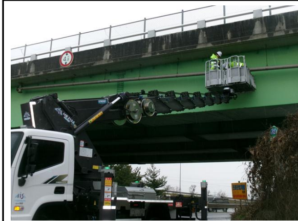
고소작업차를 이용한 근접조사
