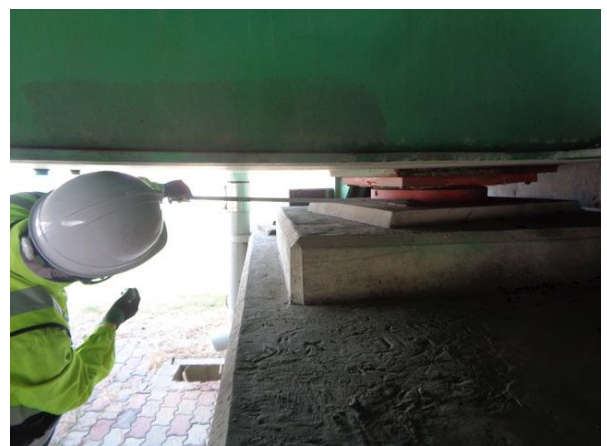
받침장치 연단거리 측정
