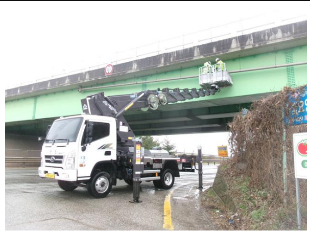
고소작업차를 이용한 근접조사
